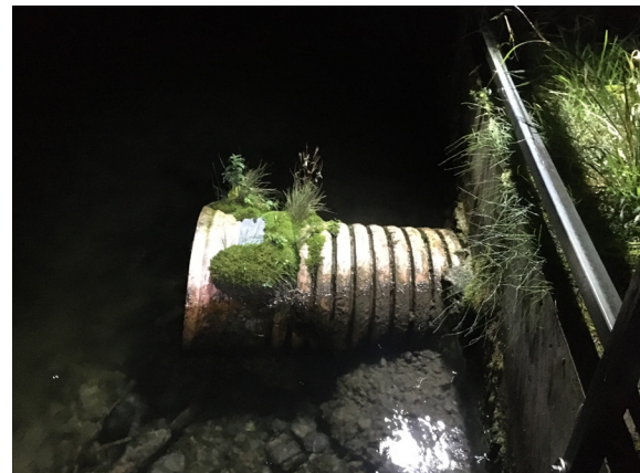
Abb.6: Nachtmessung: zu niedriger Wasserspiegel; Stauziel wird nicht eingehalten *
