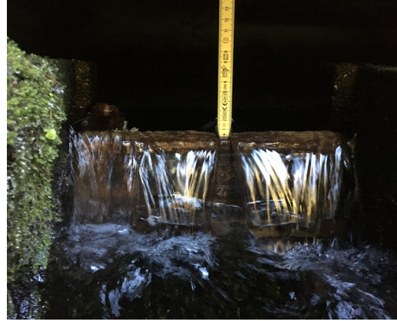
Abb.1: 1 bis 2 cm mächtiger Wasserpolster einer Fischaufstiegshilfe – garantiert unpassierbar! *
